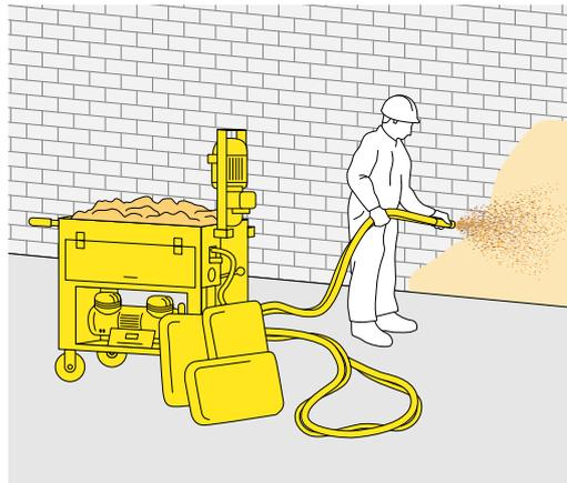
Figura 11. Proyección de yeso en un paramento vertical.
