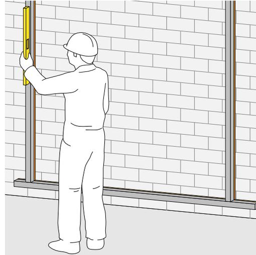
Figura 7.6. Nivelación de la mira para la ejecución de la maestra del extremo izquierdo.
