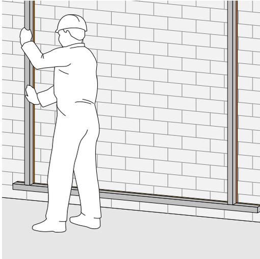
Figura 7.5. Colocación de la mira para la ejecución de la maestra del extremo izquierdo.
