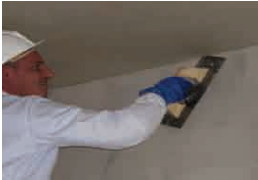
Figura 53. SILENSIS 2A- Foto corte llana
